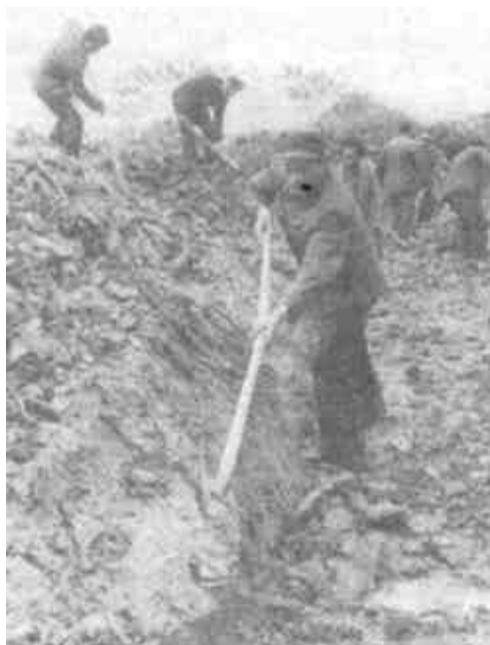
东营区龙居乡盐坨村，男女老少齐上阵，大搞农田水利基本建设。截止二月20日，共投入义务劳动工日2万余个，新扩和清淤沟渠7000余米，动用土方5000余方。图为党支部副书记马立福带领群众奋战在水利工地上。（洪连生 摄）
